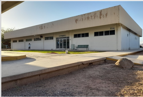
F1: Fachada principal
