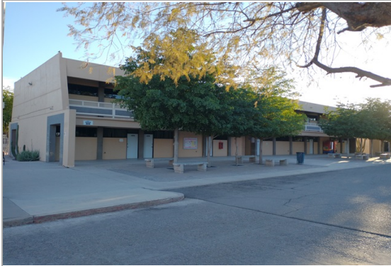
F1: Fachada principal
