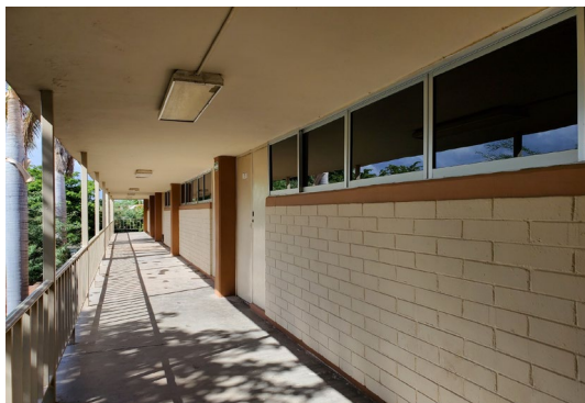
F4: Pasillo Planta Alta
