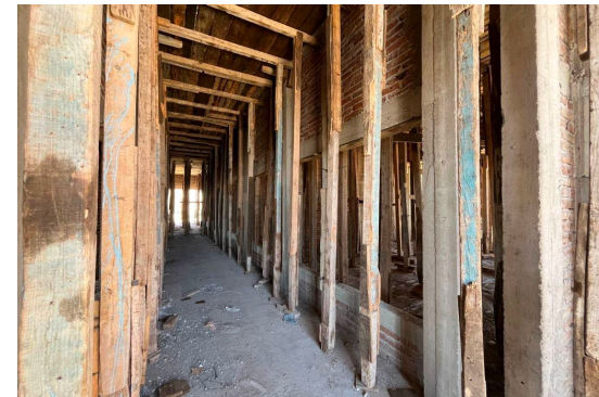
F5: Pasillo Planta Alta Aulas
