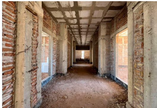
F4: Pasillo Laboratorio Planta Baja
