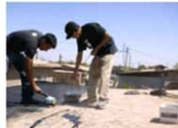
Aplicación de brea
