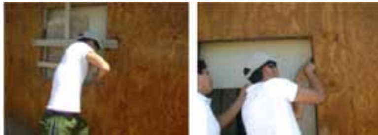
Instalación de ventana
