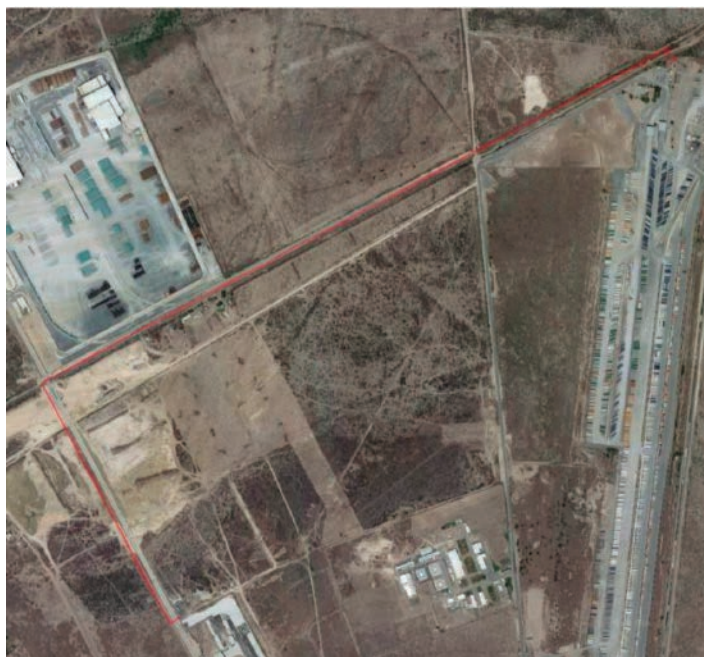
Figura 18. Diagnóstico de vibraciones Fuente: propia
