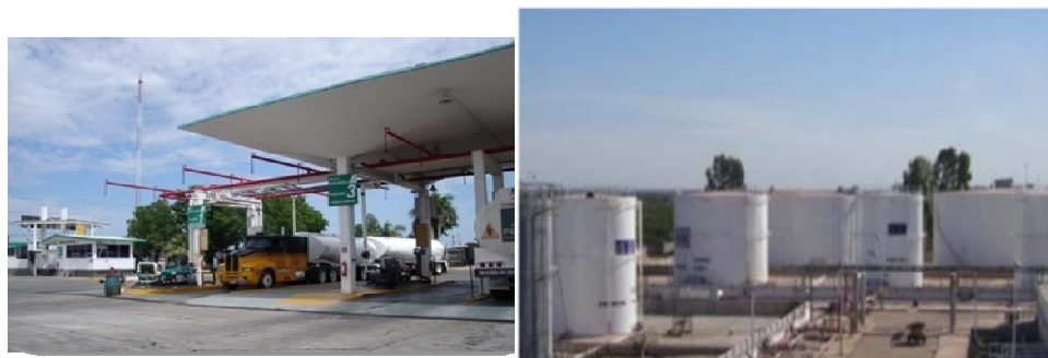
Figura 1 y 2. Área de Descargaderas y Llenaderas y Tanques de Almacenamiento son las áreas de mayor riesgo en la TAR Navojoa.
