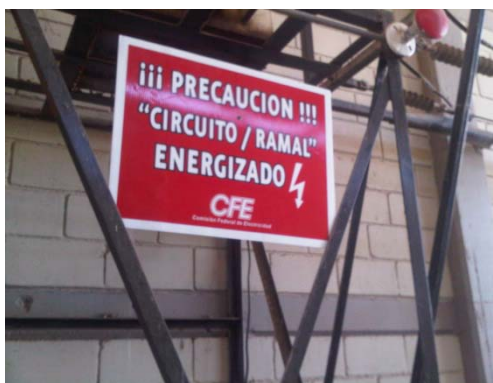
Figura 9. Colocación de letreros de seguridad. Fuente: Elaboración propia.
