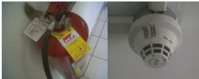
Figuras 2 y 3. Equipos de protección en Pemex-Refinación, extintor y detector de humo.
