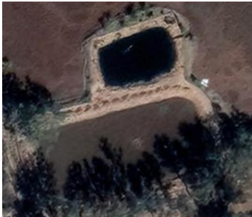
Figura 2. Sistema de tratamiento de aguas residuales mediante Humedal Artificial en la población de Martínez Valadez, municipio de Arandas, Jalisco, México
