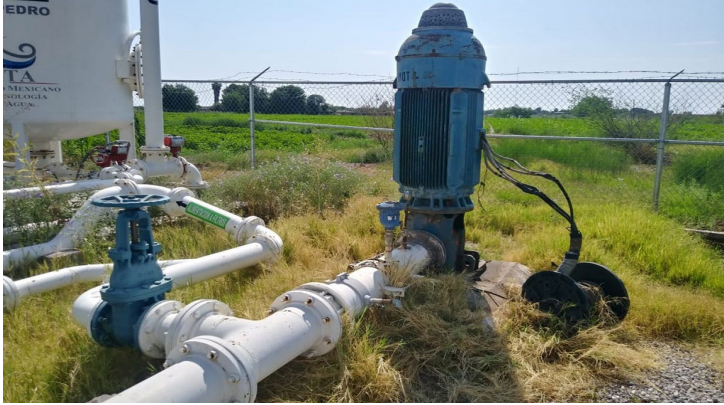
Pozo de agua salobre
