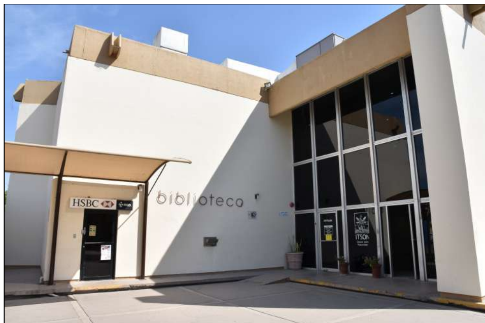
Figura 2. Edificio de Biblioteca Unidad Obregón Campus Centro
