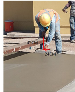
Figura 4. Evaluación de levantamiento de carga 3 (NIOSH)
