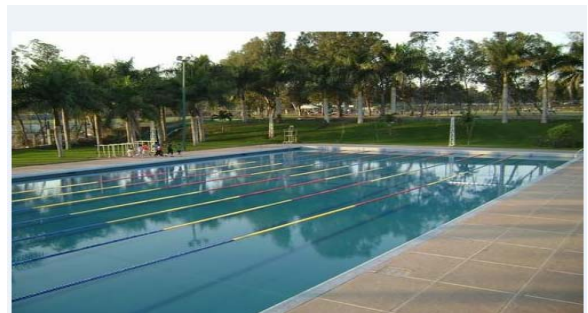
Fig. 2 Vista de la alberca olímpica universitaria.
