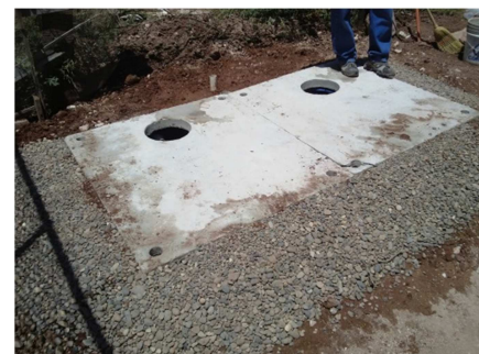
Foto 12. Instalación loza Terminado
