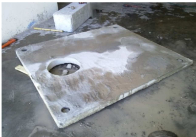
Foto 1. Losa de concreto terminada
