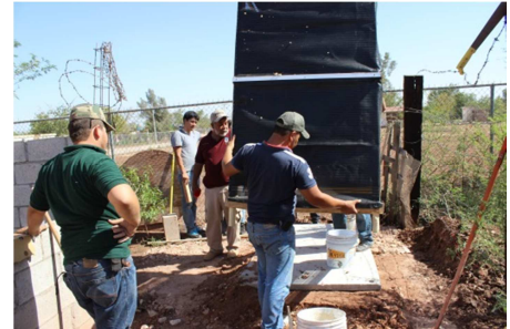
Foto 15. Colocación de caseta
