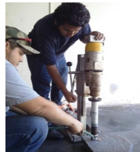
Foto 2. Barreno en losa de concreto Losa de concreto terminada
