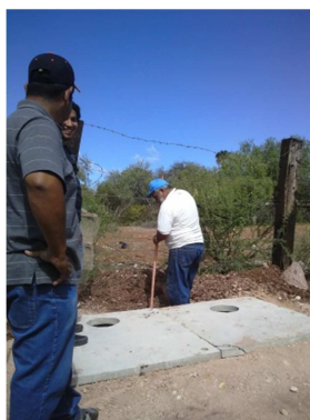
Foto 11. Instalado de Losa de concreto
