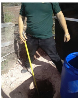
Foto 10. Excavación para celda de captación
