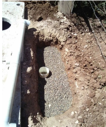
Foto 14. Construcción de filtro de captación de líquidos
