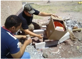
Foto 6. Armado y pintado taza de baño
