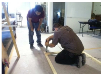
Foto 3. Estructura de madera terminada
