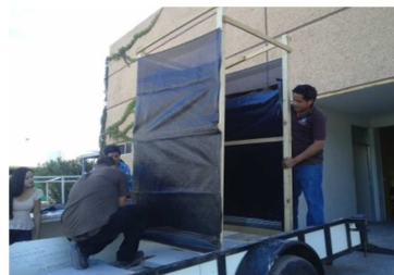
Foto 5. Estructura y Cubrimiento de caseta terminada
