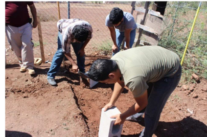
Foto 9. Compactación terreno natural
