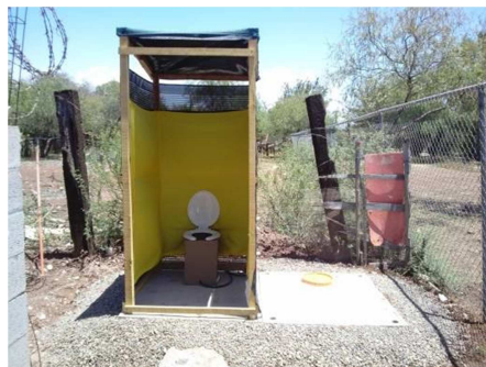
Foto 18. Prueba de instalación de caseta
