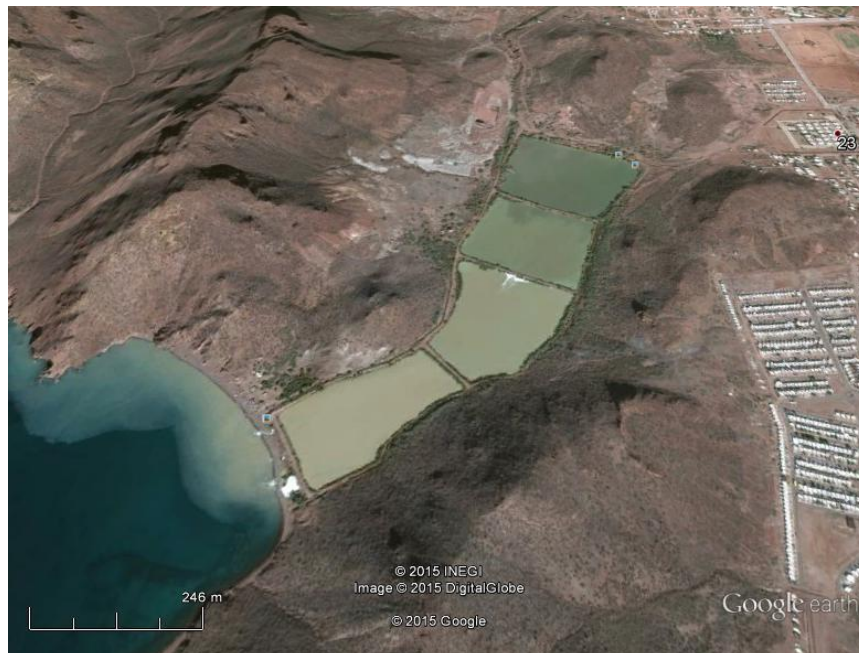
Fig. 2. Lagunas de estabilización, Guaymas, Sonora. Se observa la pluma de descarga en el mar.
