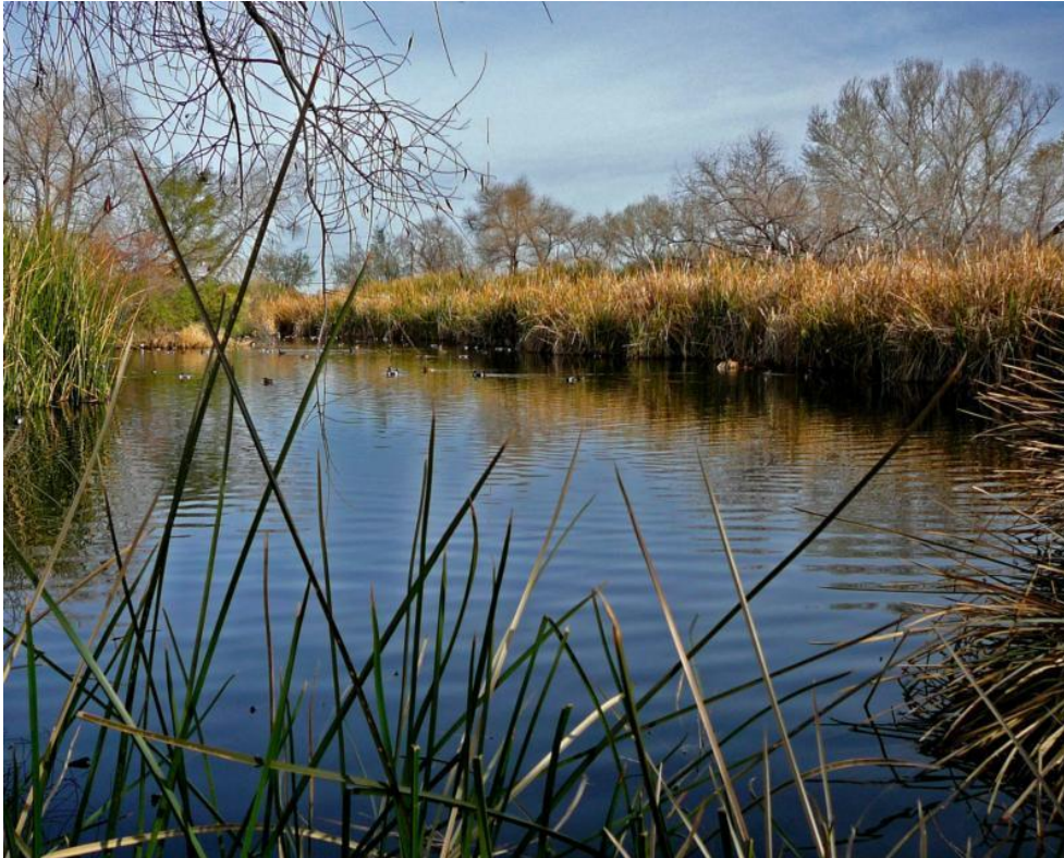
Fig. 3. Humedal construido de flujo inundado ( Sweetwater wetland ) en Tucson, Arizona.
