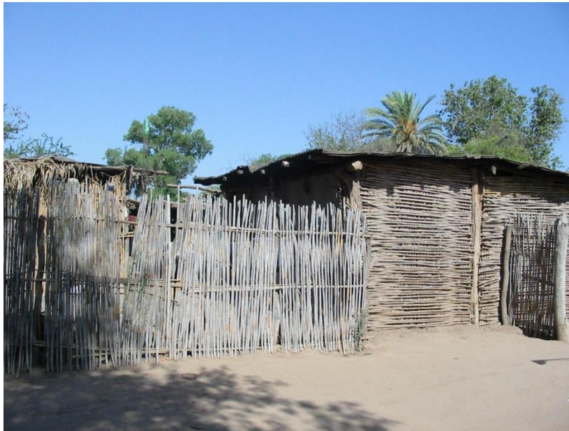
Fig. 6. Construcción de carrizo comunidades Yaquis.
